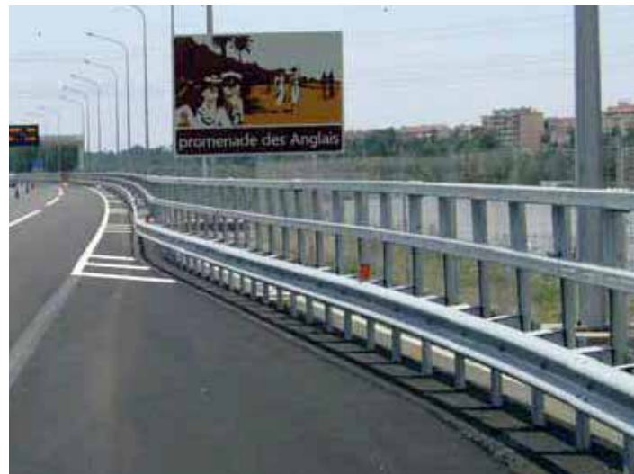
BARRERA DE SEGURIDAD BMSNC CON DOS VALLAS
